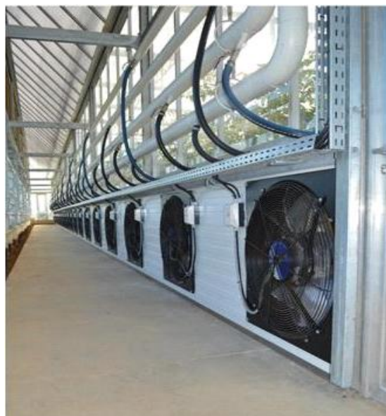
Рисунок 2 – Общий вид вентиляционного блока: слева наружная стена с «мокрыми» экранами (матрацами); справа – теплица с вентиляторами на каждый ряд растений
